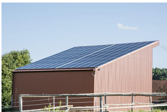
Figur 4. Eksempel på solceller montert på pulttak. Med en slik utforming unngår en skyggeproblematikk mellom solcellerader, og en får en høy utnyttelse (tv). For å få en mer aerodynamisk utforming av taket kan det vurderes å forme en helning mot nordøst på enden av taket.
