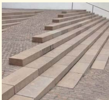
Figur 2: En større trapp med rekkverk er kombinert rullestolrampe til venstre. Materialer er valgt for å sikre visuell likhet mellom elementene.
