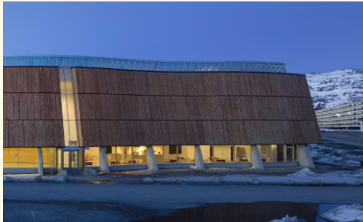
Figur 7 - Åpent/lukket: Et eksempel til illustrasjon på hvordan fasadeutformingen kan bidra inkluderende (1. etg) i møte med gate og publikum. Fasader kan likefullt bidra ekskluderende og privatiserende (2. etg og oppover). Utforming av bygninger i sentrum av Andenes bør utvise forståelse for ansvaret og muligheten de har til å bruke fasaden både til å skape privatliv internt, og til å skape aktivitet og attraktivitet i gate og nærmiljøet. Bilderrettigheter: Adam Mørk
