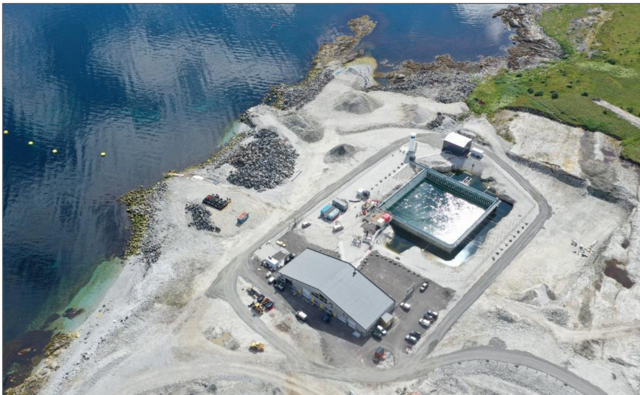
Figur 2-5. Andøy Industripark Kvalnes under utbygging – admin.bygg og oppstartsbasseng (Foto: Andfjord Salmon).
