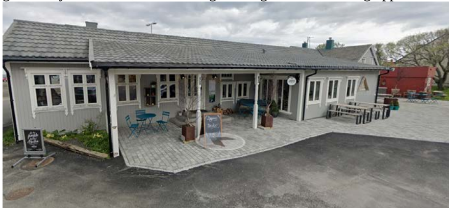
Arresten. Bygget som skal rives og erstattes med nytt er den røde delen til høyre i bildet.
