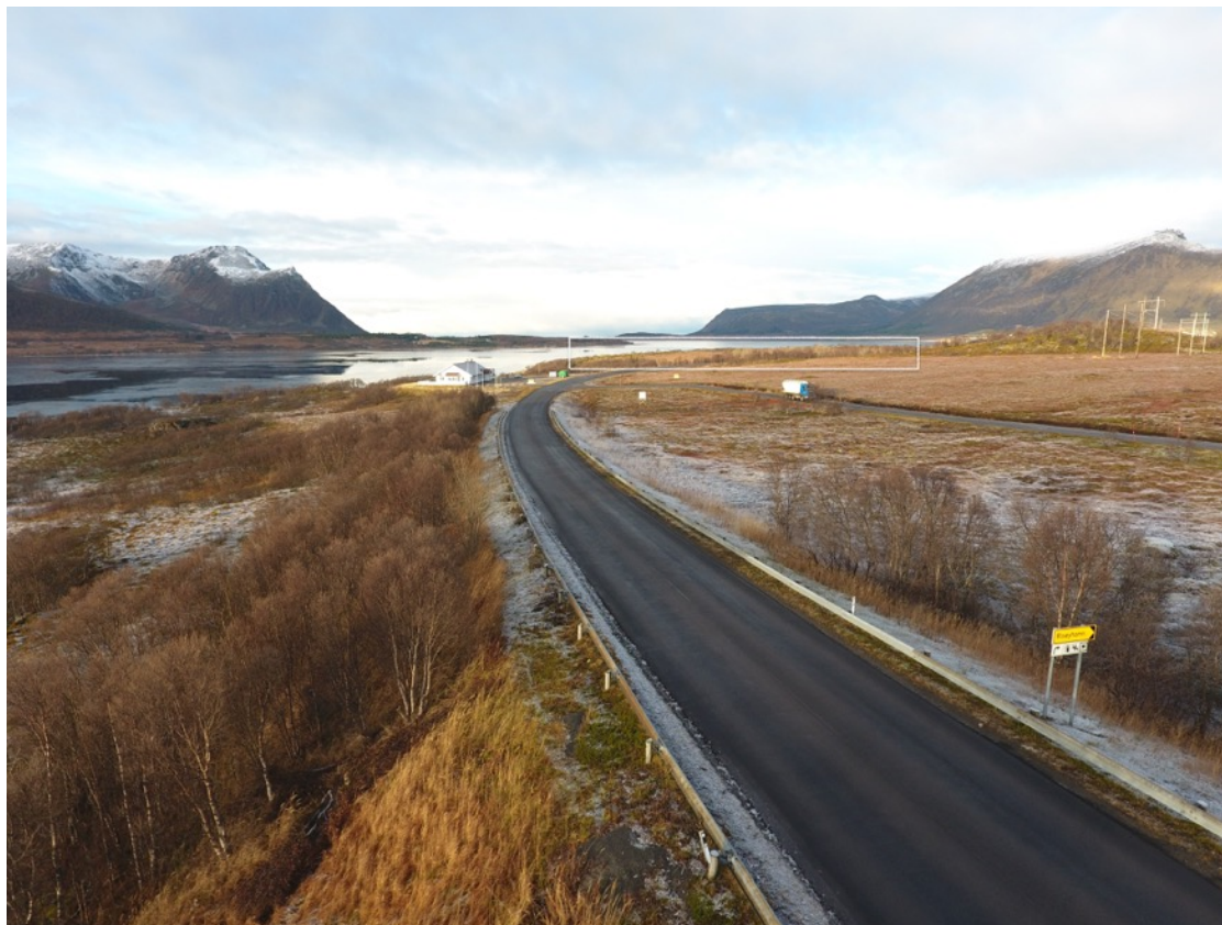
Sett fra Risøyhamnbrua og nordover.
