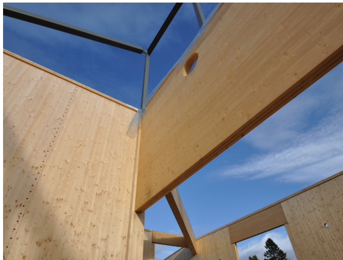
Stokmarknes ungdomsskole, under bygging i massivtre med løsning for fornybar energi. Står ferdig til skolestart i 2020. Foto: Stein Petter Hillestad.
