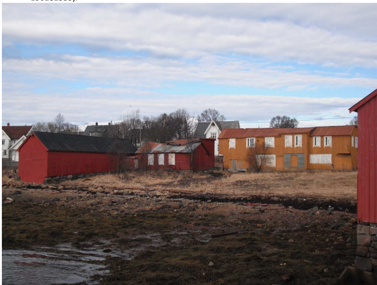
Naustet helt til venstre i bildet, og verksted til høyre.
